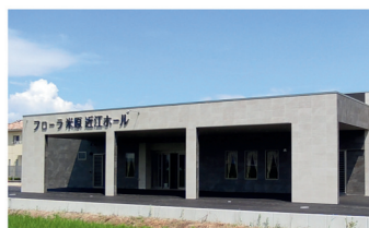
フローラ米原 近江ホール様 新築
